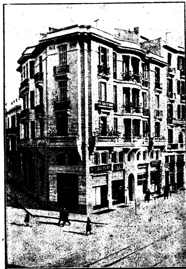
Maison d'appartements rue Tsimiski
